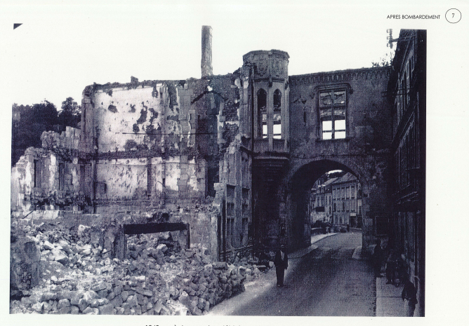
1940_après les premiers déblaiement_ISV.png
